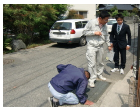
小田 / 排水用マス設置 (現地調査)
